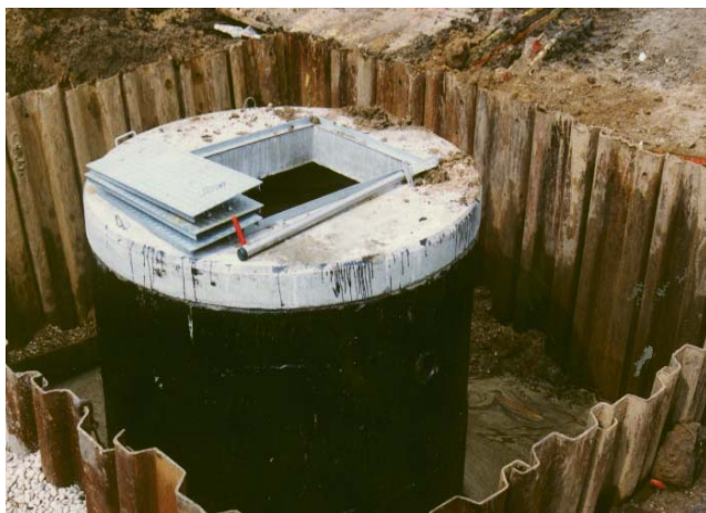
Baugrube Pumpwerk
