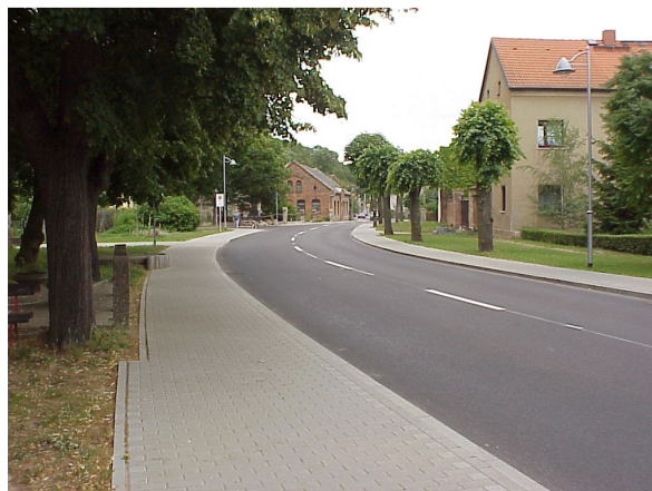
Hauptstraße nach der Sanierung
