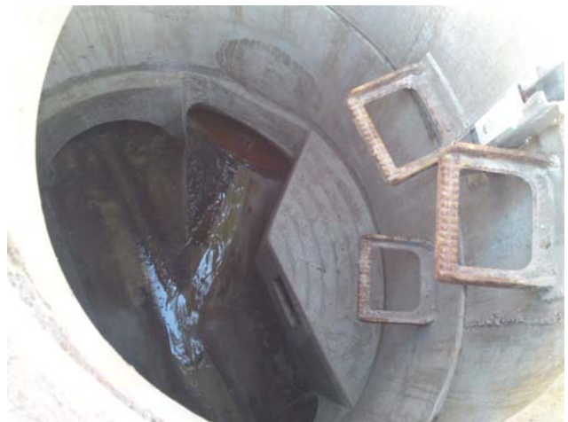
... nach Abschluss der Baumaßnahme
