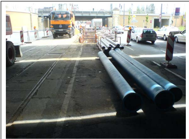
Verlegung TWL DN 300 GGG, bei beidseitiger Verkehrsführung an der Baustelle vorbei
