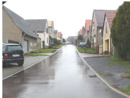
Thurmsplan Süd nach der Erneuerung
