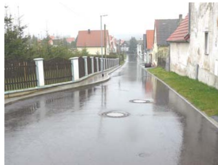
...und nach der Erneuerung
