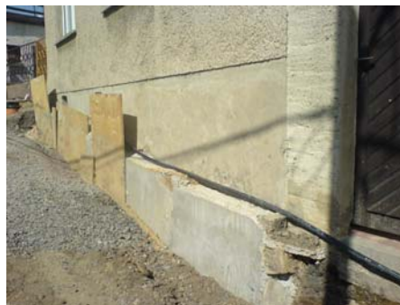
Gebäudeunterfangung im Engbereich
