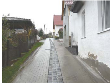
...und nach der Erneuerung
