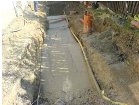
...und Verfüllung mit Bodenmörtel
