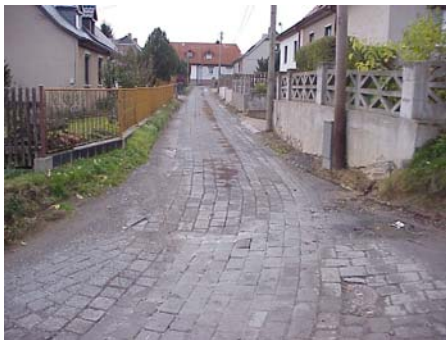
„Siedlung Stich“ vor Erneuerung
