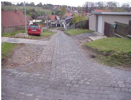
„Siedlung“ vor Erneuerung
