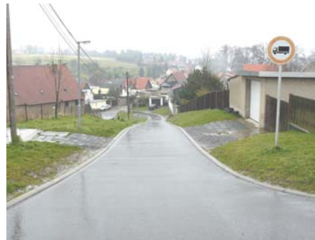
...und nach der Erneuerung
