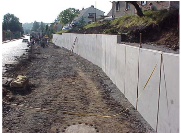
Böschungssicherung mit Winkelstützelementen
